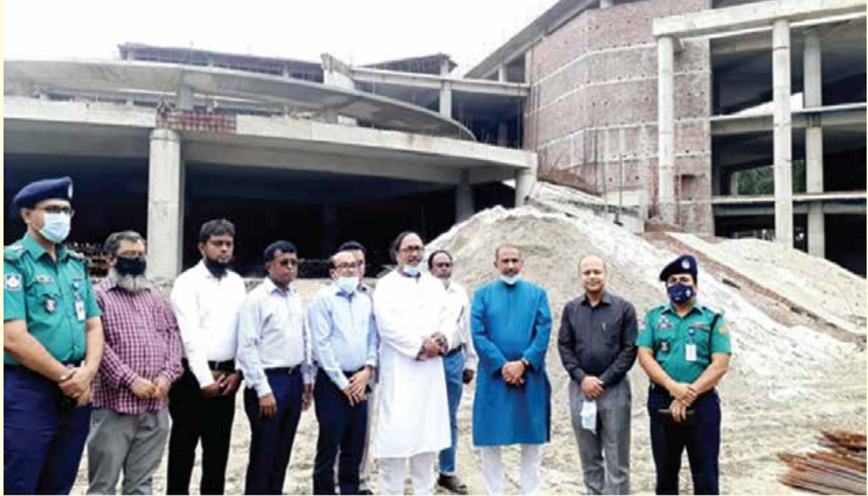
রাজশাহী নভোথিয়েটার স্থাপনের কাজ পরিদর্শন করছেন মাননীয় মন্ত্রী স্থপতি ইয়াফেস ওসমান
